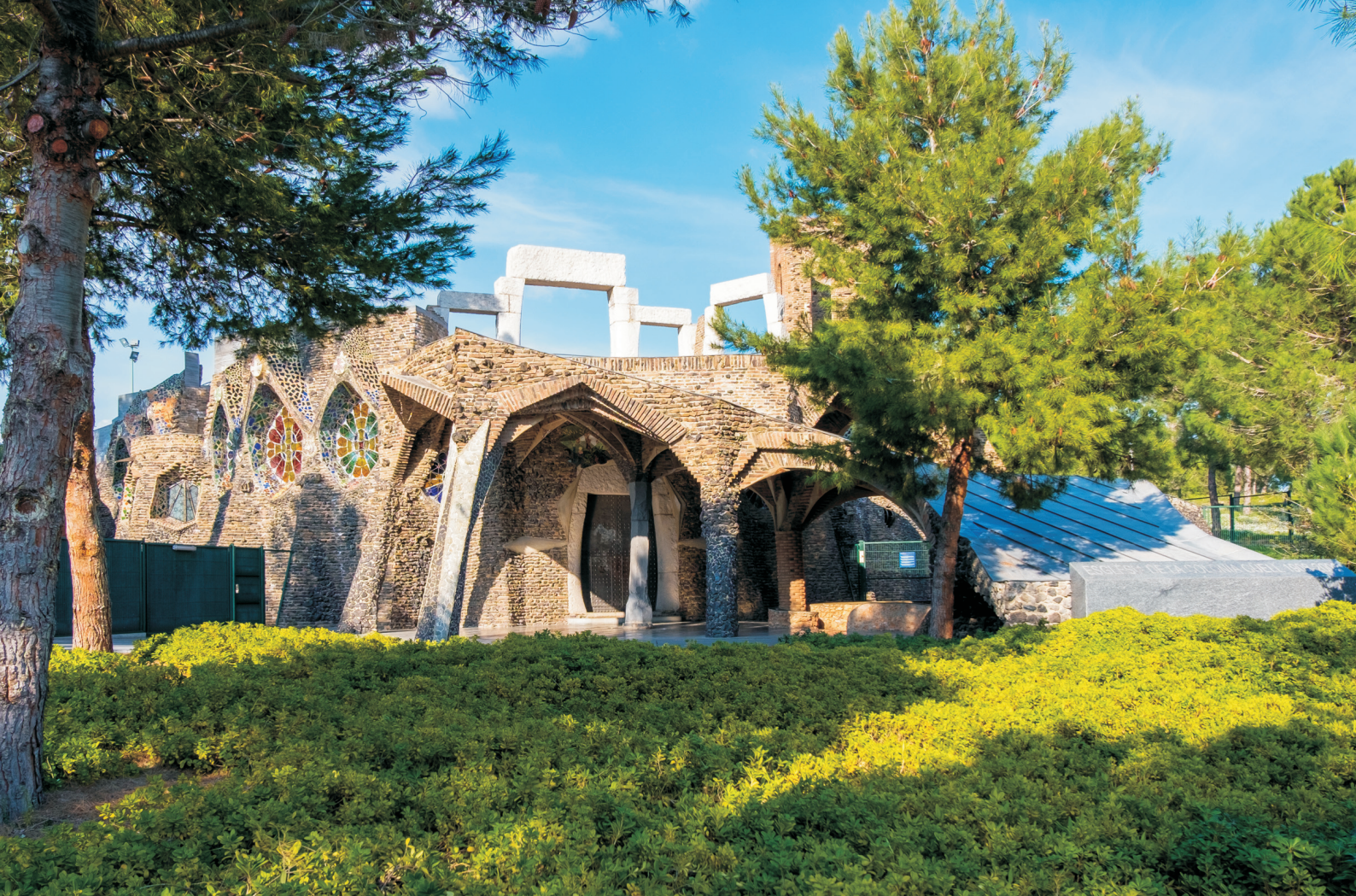
Ryc. 5. Geometryczna bryła z pochylonymi słupami w Colonia Güell; źródło: © alzamu79 – stock.adobe.com Fig. 5. Geometric solid with inclined pillars in Colonia Güell; source: © alzamu79 – stock.adobe.com
