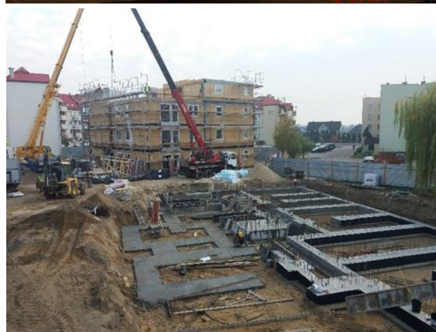
Rys. 3. Budowa budynku w technologii panelowej (Źródło: Unihouse)
