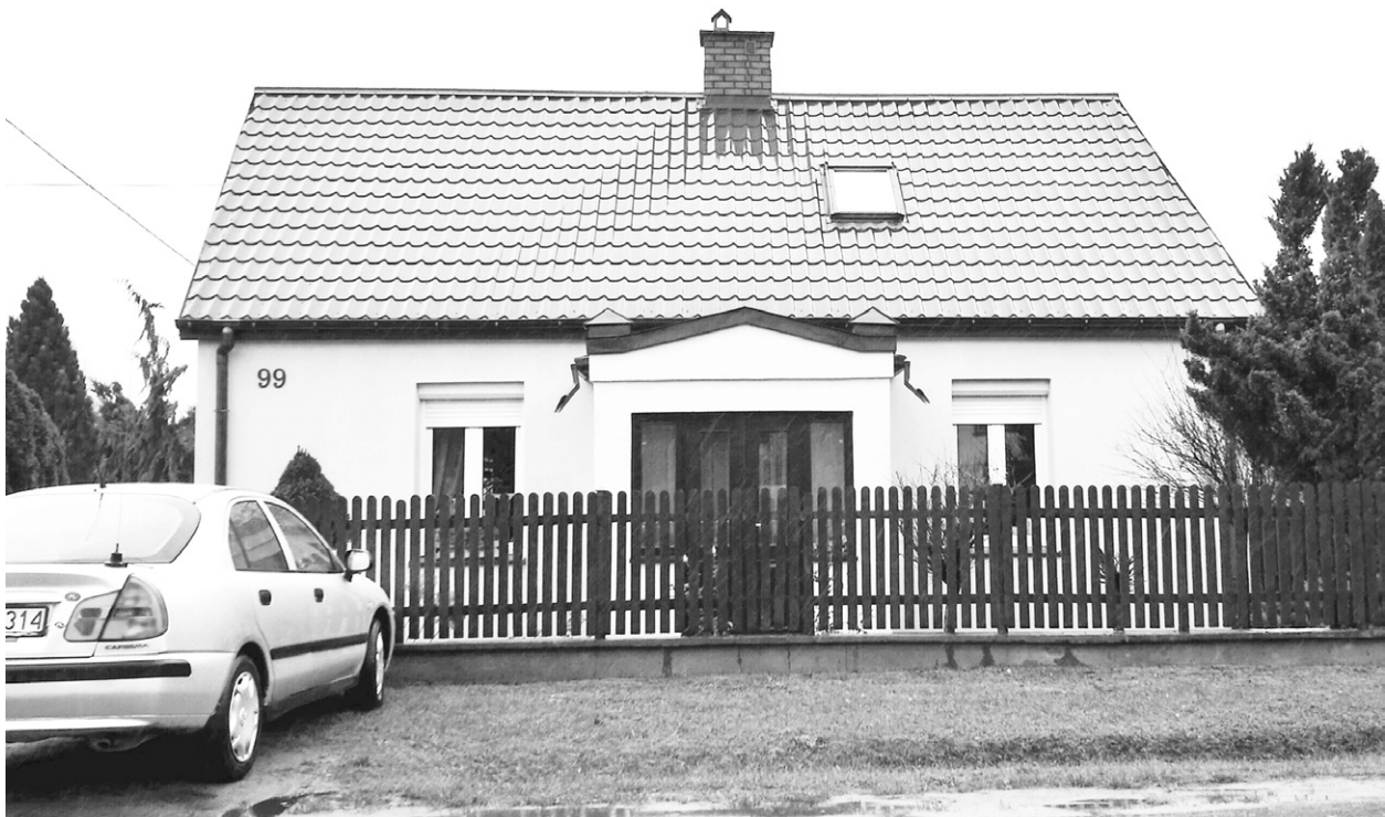
Ryc. 1. Dom z polan opałowych przy ul. Sikorskiego w Ostrowi Mazowieckiej, widok od strony ulicy. Fot. A. Dobrońska, 2017 Fig. 1. A cordwood-constructed house in Ostrów Mazowiecka, Sikorskiego St.; photo by A. Dobrońska, 2017
