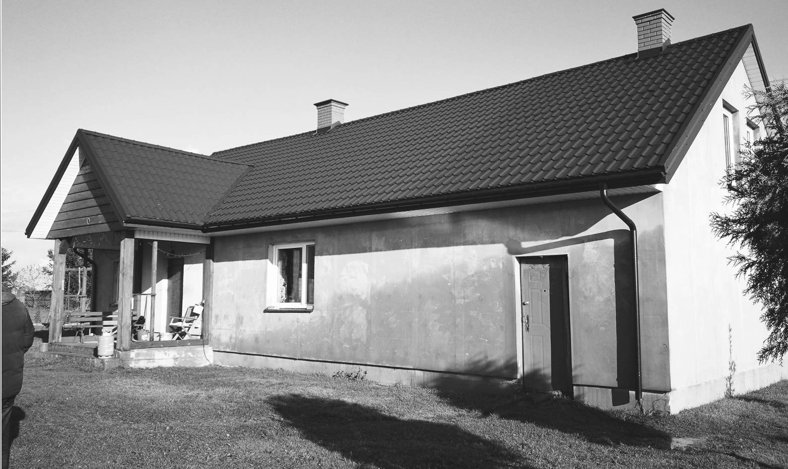
Ryc. 3. Dom z polan opałowych w Złotorii koło Ostrowi Mazowieckiej, widok od strony podwórka; fot. A. Dobrońska, 2017 Fig. 3. A cordwood-constructed house in Złotoria (Ostrów Mazowiecka commune; a court view); photo by A. Dobrońska, 2017
