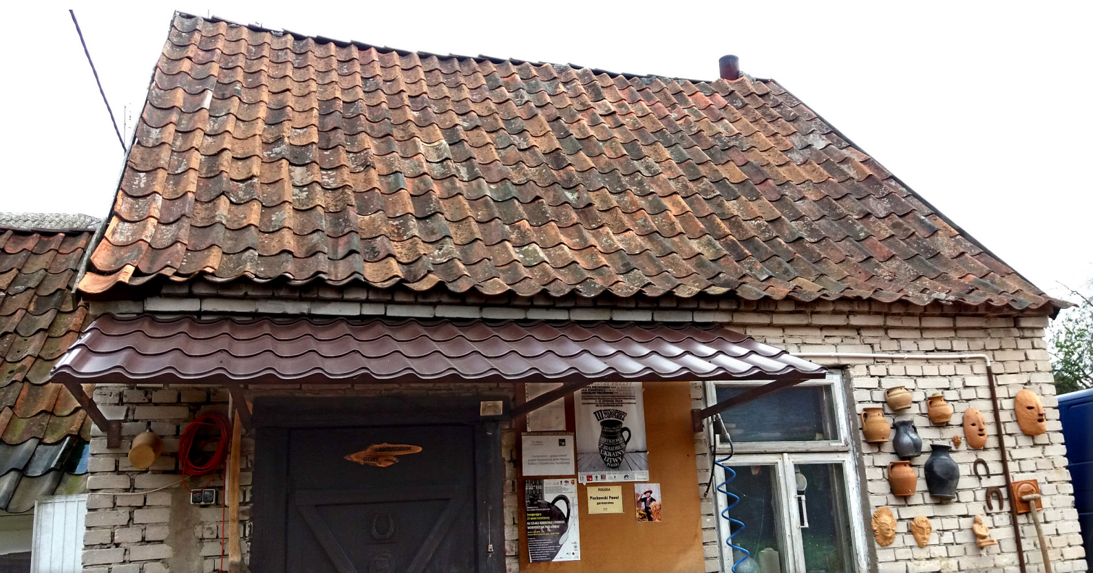
Ryc. 5. Pracownia garncarska Pawła Piechowskiego (piwnica budynku ma ściany z dachówek); fot. J. Ciecuch i P. Gołębiowski, 2016 Fig. 5. Pottery studio of Paweł Piechowski, having tiles-constructed basement walls and brick upper walls; photo by J. Ciecuch & P. Gołębiowski, 2016
