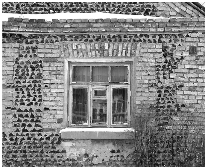
Рис. 11. Fragment ściany domu w miasteczku Strubnica, ul. Sadowaja 40; fot. J. Mazets Fig. 11. Stackwall house in Strubnitsa, Sadovaya St. 40; photo by Y. Mazets Рис. 11. Стена дома в д. Струбница, улица Садовая 40; фото: Ю. Мазец
