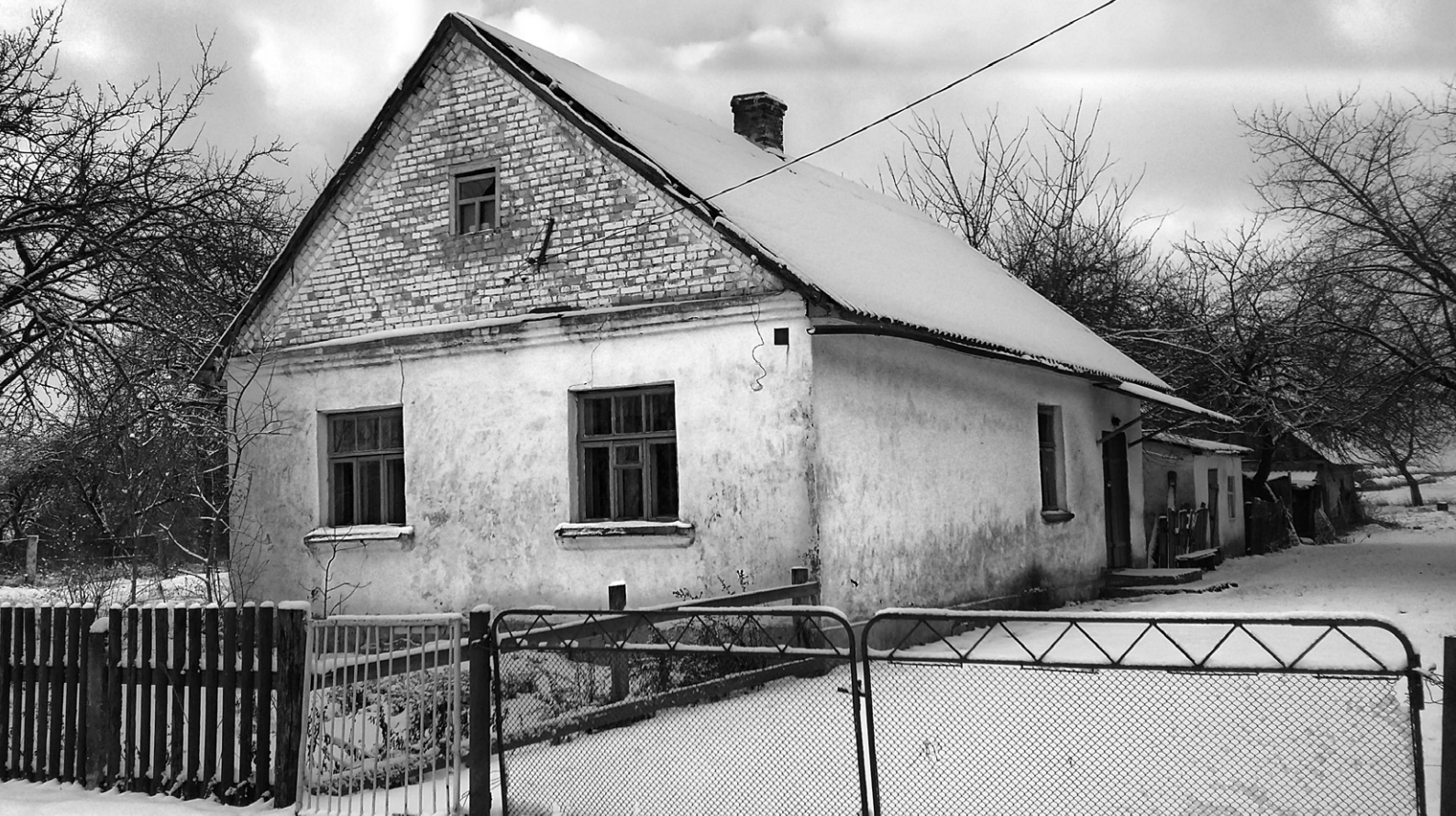
Рыс. 6. Дом в местечку Струбница, ул. Садовая 63; фот. J. Mazets Fig. 6. Stackwall house in Strubnitsa, Sadovaya St. 63 (photo by Y. Mazets) Рис. 6. Дом в д. Струбница, улица Садовая 63; фото: Ю. Мазец
