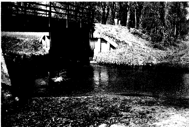
Most na rzece Wołkuszanke, na której ustalono granicę sowiecko-niemiecką
