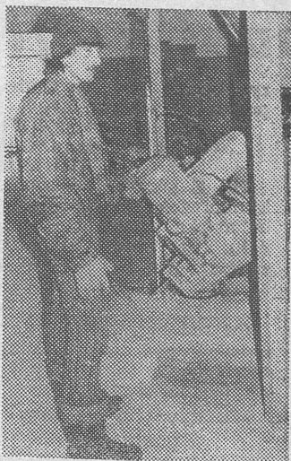
Obsługujący brykietarkę Bogdan Ciereszko „wypuszcza” z niej w ciągu godziny ponad pół tony „paliwa”.
