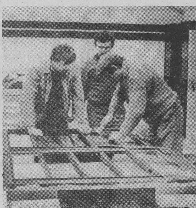
Ekipa stolarzy w trakcie prac wykończeniowych wnętrza Domu Nauczycieli. Fot. R. LYSIONEK
