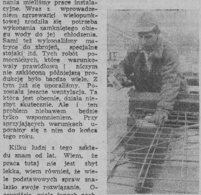
— Od tego wszystko się zaczyna — przy zbrojeniu płyty pracuje Andrzej Butkiewicz
