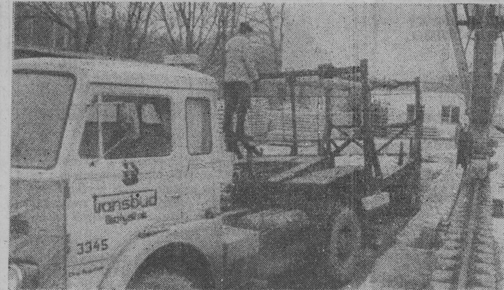
Gotowe elementy ścienne za moment odjadą na jeden z placów budowy prowadzonych przez APB.
