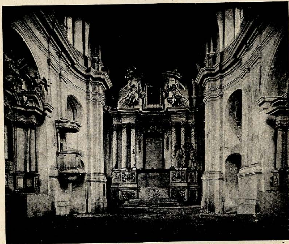
Wnętrze kościoła pofranciszkańskiego w Drohiczynie.
