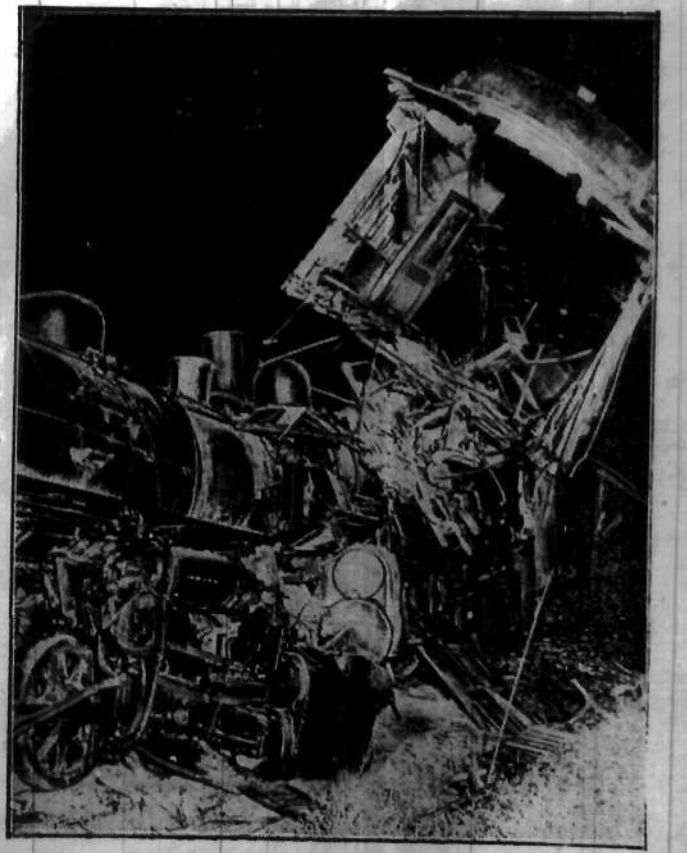
Grzy dwu pociągów osobowych, które zderzyły się pod miejscowością Fonten w stanie Michigan (U. S. A.) drugocąc się doszczętnie. Mimo wielkiej ilości nasażerów cudem obyło się bez wypadku śmiertelnego, ledwo 7 osób uległo silnemu wstrząsowi nerwowemu.
