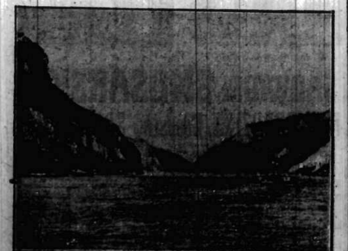
Rządy Rumunii i Jugosławii rozwiązują obecnie problem budowy olbrzymiej elektrowni wodnej w miejscu przełomu Dunaju przez góry Bałkańskie, tworzącej sławne „Żelazne wrota”. Projektowana elektrownia pokryłaby zapotrzebowanie elektryczności obu krajów.
