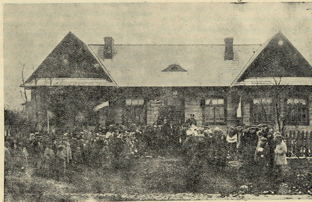
Nowy budynek szkolny.
