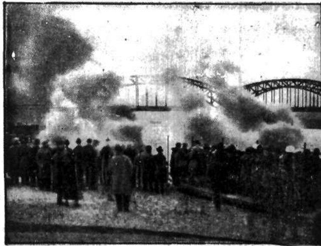
Niesamowity widok miała wczoraj Warszawa! Smugi dymu zasnuły most kolejowy. Była to jedna z imprez propagandowych w przeddzień zakończenia tygodnia L.O.P.P. — pokaz zademontażu mostu kolejowego na Wiśle. Tłumy publiczności z zapartym oddechem śledziły ten niezwykły widok.
