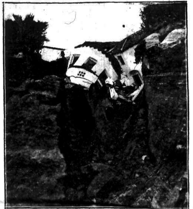
W San Clemente (Kalifornia) powstała wskutek trzęsienia ziemi wielka szczelina. Na zdjęciu willa zapadła do powstałej szczeliny.
