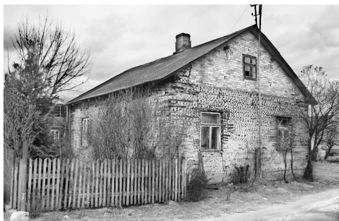
Ryc. 8. Budynek z polan opałowych w Brykach; fot. M. Kurnicka, 2015
