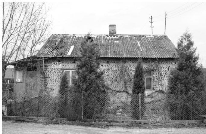
Ryc. 7. Budynek z polan opałowych w Brykach; fot. M. Kurnicka, 2015
