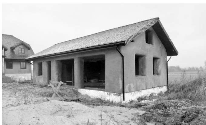
Ryc. 2. Garaż słomogliniany w Wysokim Mazowieckiem; fot. N. Pietruszewicz, 2015
