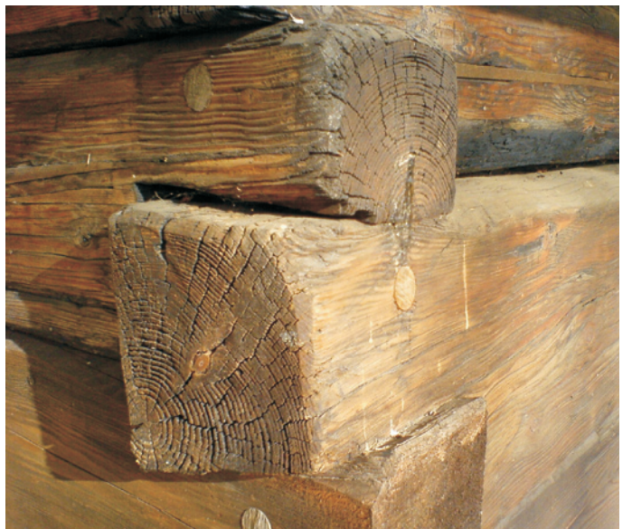
Ryc. 5. „Ostatki”, czyli zakończenia bierwion w konstrukcji wieńcowej, występowały w kościołach drewnianych prawdopodobnie już w XV w. Tu na przykładzie Kościoła w Żernicy z 1648 r.; fot. autor, 2007
