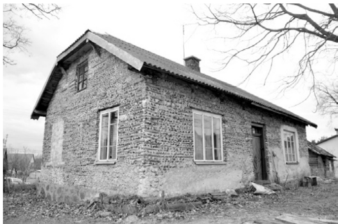
Ryc. 4. Budynek z polan opałowych w Mścichach; fot. N. Pietruszewicz, 2015
