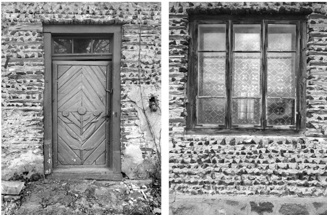
Ryc. 6. Budynek z polan opałowych w Mścichach – węgry i nadproża ; fot. N. Pietruszewicz, 2015
