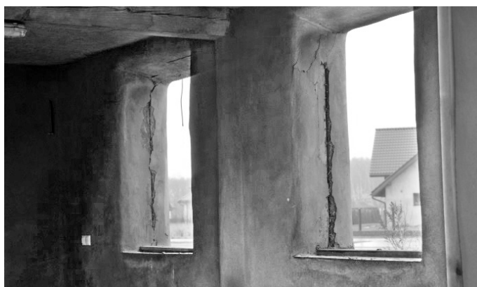
Ryc. 3. Garaż słomogliniany w Wysokim Mazowieckiem – detal podczas prac budowlanych; fot. N. Pietruszewicz, 2015
