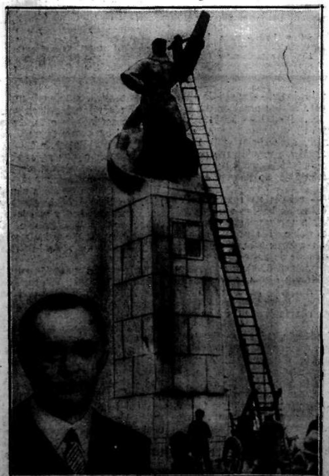
Na placu Unji Lubelskiej w Warszawie trwały wczoraj ostatnie gorące prace szkalowania przed odsłonięciem pomnika Lotnika, data: artysty rzeźbiarza prof. Edwarda Wittima.
