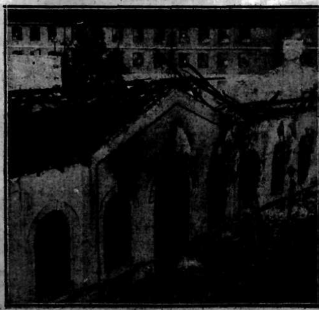
Państw. groźnego pożaru padła wczoraj w Warszawie fabryka wyrobów izo-lacyjnych „Isolator” przy ul. Czerniakowskiej 166. Na zdjęciu srużony budynek fabryczny.
