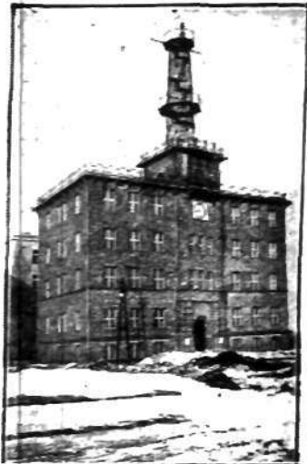
Obserwatorium Wydziału Morskiego w Gdyni. (Do artykułu o bok).
