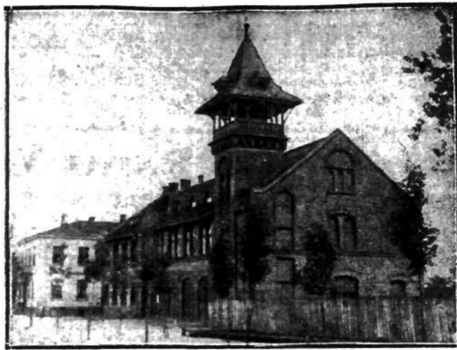
Budynek straży pożarnej w Błoni, będący jednocześnie siedzibą szkoły powszechnej i jedynego w mieście lokalu rozrywkowego kina „Venus”.
