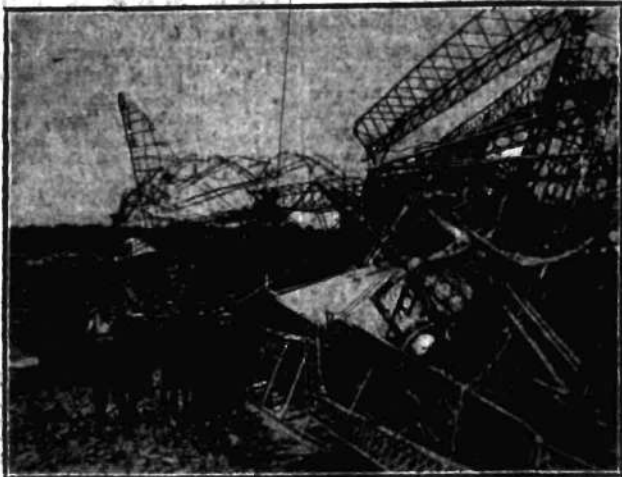
Resztki szkieletu sterowca R 101 pod Beauvais.
