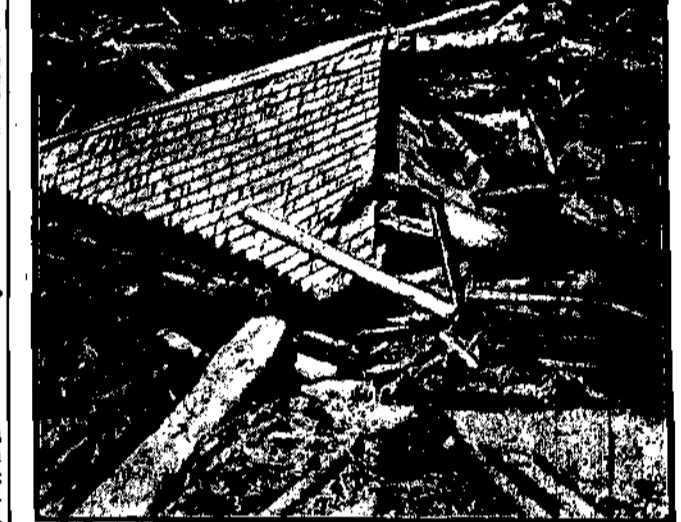
Zniszczenie w miejscowości Kami Pazawa.
