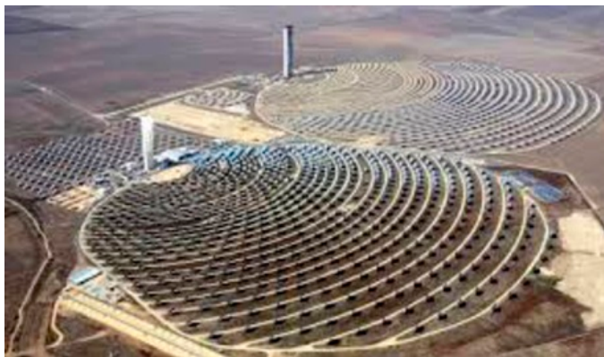
Il. 3. Słoneczna elektrownia wieżowa, Australia ( www.fizyka.net.pl )
