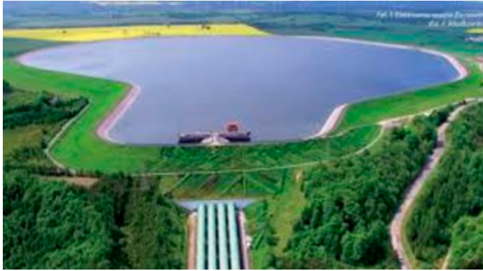
Il. 2. Widok na elektrownię wodną, Żarnowiec ( www.globenergia.pl )
