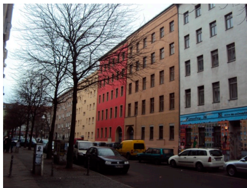
Il. 4. Widok na odnowione kamienice w dzielnicy Kreuzberg (fot M. Wilkosz-Mamcarczyk)
