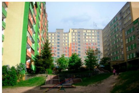
Il. 54. Osiedle Dziesięciny, zrealizowane przy współudziale mieszkańców wewnątrz międzyblokowe (fot. M. Kłopotowski)
