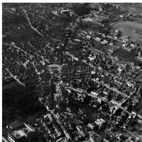
Il. 1. Fotografia lotnicza, Centrum Białegostoku z widoczną strukturą przestrzenną miasta (na fotografii w lewym dolnym rogu widoczny jest dach pałacu Branickich), połowa lat dwudzieste XX wieku ( http://www.ciekawepodlasie.pl/ )
