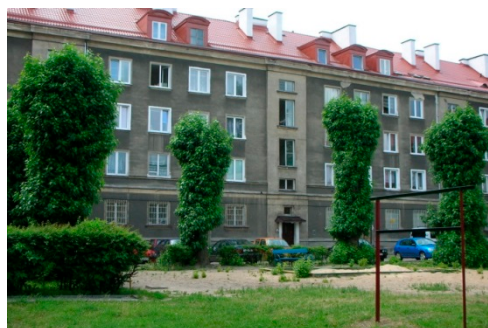
Il. 12. Wnętrze bloku mieszkalnego z połowy lat pięćdziesiątych. Na fotografii widoczny jest współczesny stan zagospodarowania terenu (fot. M. Kłopotowski)
