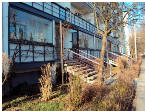
Il. 6. „Ogrody przybłokowe” przed oknami mieszkań parterowych, widoczna także zielen wertykalna w postaci pnączy, oraz odnowiona fasada budynku (fot. M. Wilkosz-Mamcarczyk)
