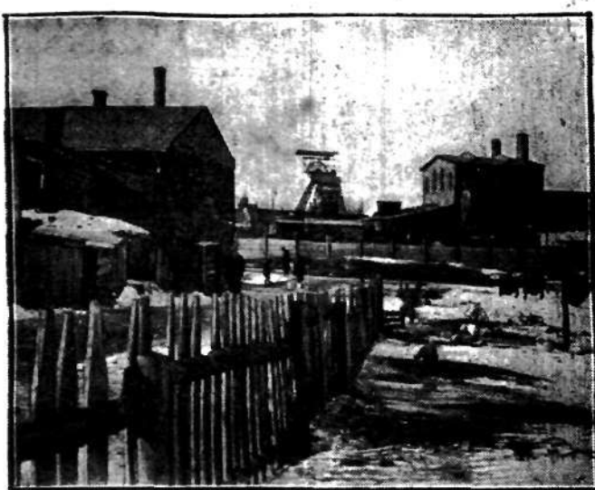
Na krawcach Sosnowca — w głębi kopalnia „Hr. Renard”.
