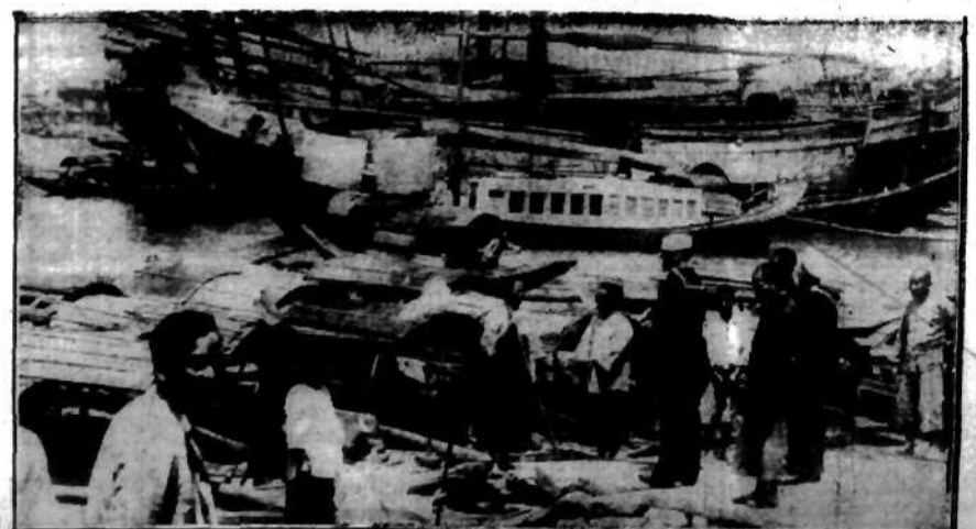
Port chiński w północnej dzielnicy Szanghaju na rz. Hoang-pu zatłoczony dzonkami i archaicznymi żaglowcami.
