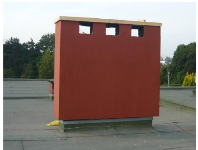
Rys. 1. Komin słoneczny – strona południowa, strona północna
