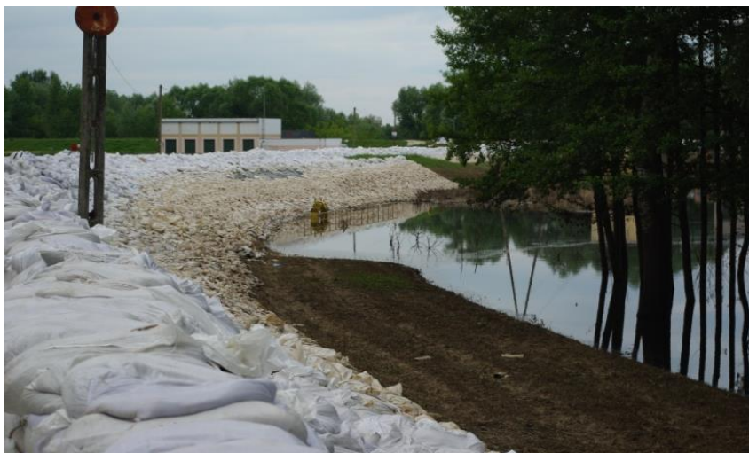
Rys. 1. Wał przeciwpowodziowy w sąsiedztwie przepompowni w Dobrzykowie, umocniony i podwyższony workami z piaskiem, który po przedłużeniu do drogi wojewódzkiej 575 stanowił przegradę dolinową 20.06.2010 roku (fot. B. Piątkowska)
