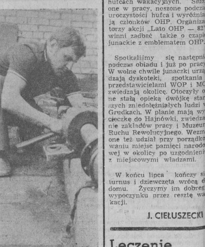
Wymiany wahu wentylatora wyciągu spalin w kotłowni, dokonuje Marian Rogowski.
