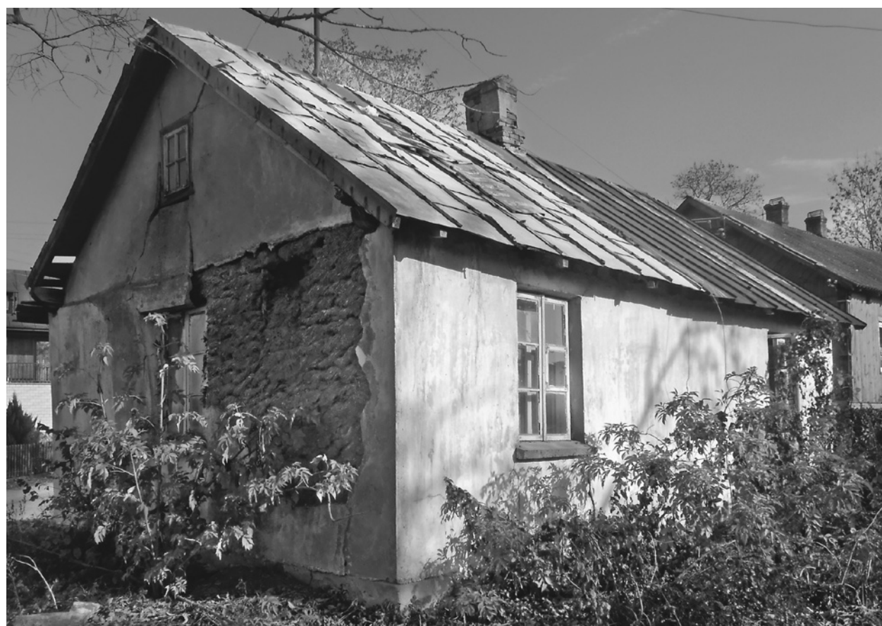
Ryc. 1, 2. Dom o konstrukcji strychulcowej we wsi Winna-Poświętna 16; fot. M. Czarkowska, 2015 Fig. 1, 2. Wattle-and-daub house in Winna-Poświętna (No. 16); photo by M. Czarkowska, 2015
