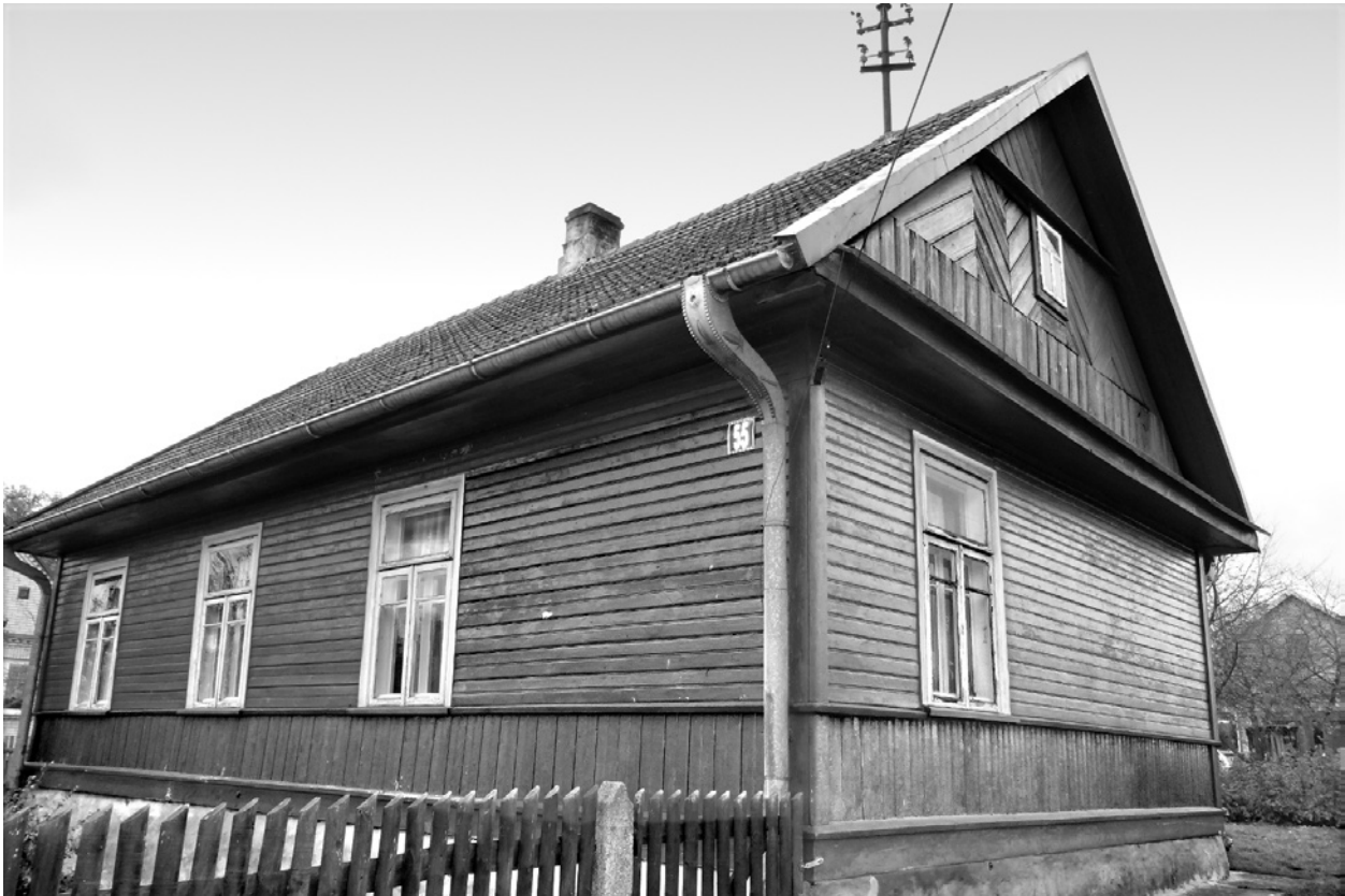
Ryc. 15. Drugi z trzech zinventaryzowanych domów w Nowej Woli – widok od strony ulicy (fot. M. Szelech, październik 2014) Fig. 15. The second of the three surveyed houses in Nowa Wola, Michałowo commune (photo by M. Szelech, October 2014)
