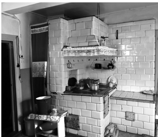
Ryc. 9. Piec kuchenneo-wielofunkcyjny w pierwszym z trzech zinventaryzowanych domów w Nowej Woli, będący częścią bardziej rozbudowanego systemu piecowego (fot. M. Rogozińska, październik 2014 – ujęcie 1 na ryc. 14)
