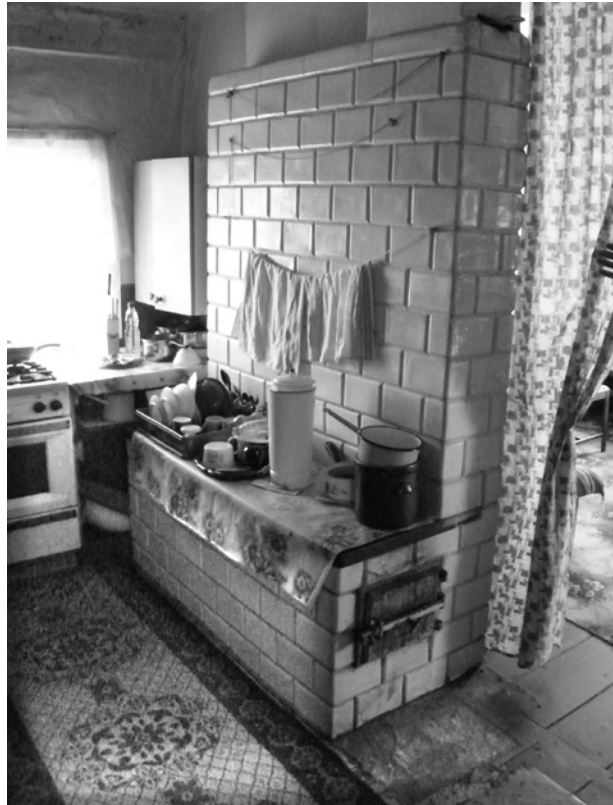
Ryc. 8. Piece kaflowe w dwóch domach we wsi Leonowicze w gm. Michałowo (każdy z pieców jest częścią bardziej rozbudowanego systemu w danym domu; fot. J. Szewczyk, lipiec 2010)
