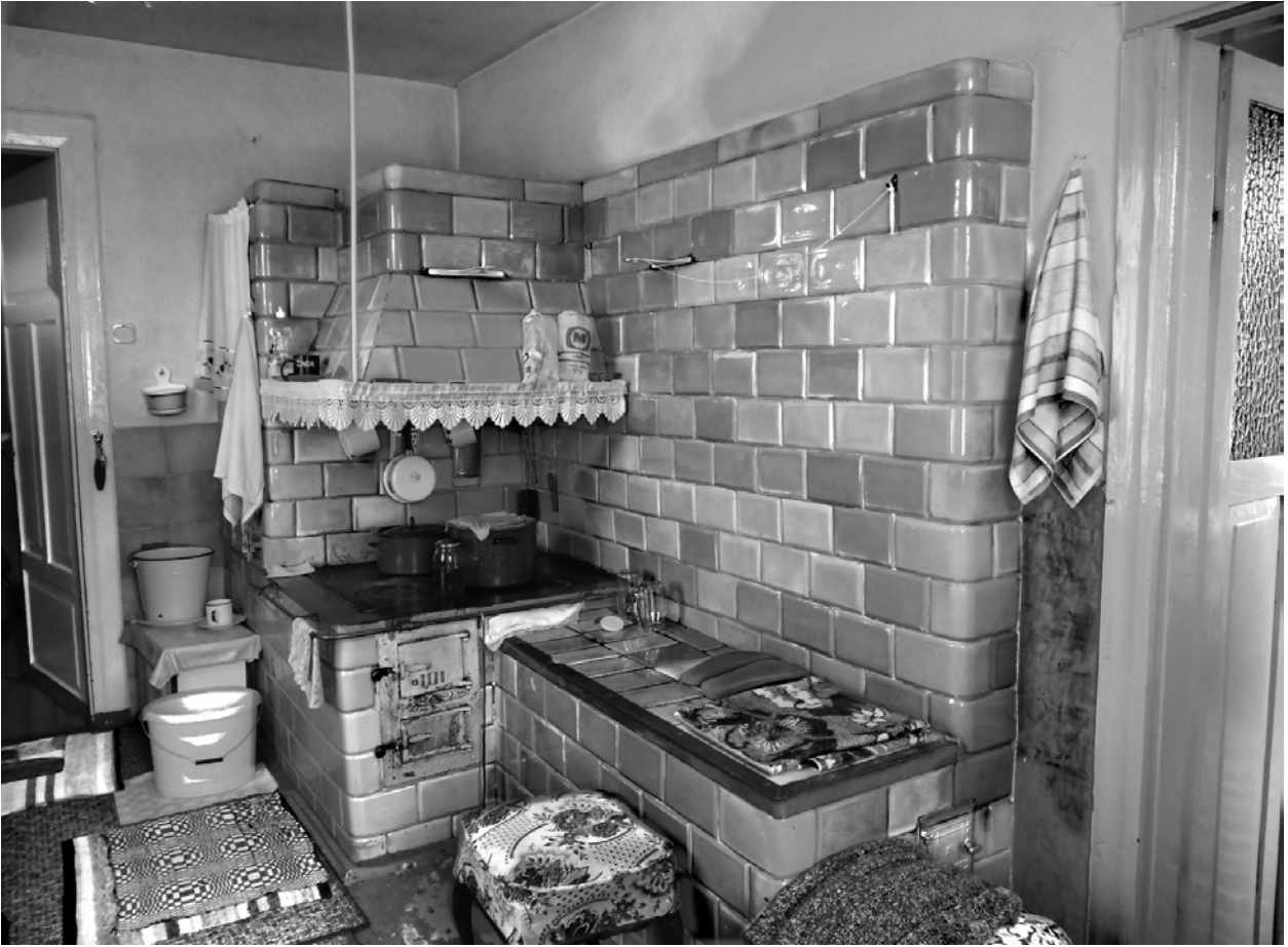
Ryc. 11. Piec kuchennie-wielofunkcyjny w drugim z trzech zinventaryzowanych domów w Nowej Woli, będący częścią bardziej rozbudowanego systemu (fot. M. Szelech, październik 2014 – ujęcie 2 na ryc. 17)
