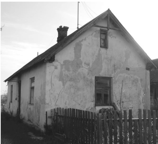
Ryc. 4, 5. Dom o konstrukcji strychulcowej we wsi Wyszonki-Wypychy 39; fot. M. Czarkowska i U. Kuczyńska, 2015 Fig. 4, 5. Wattle-and-daub house in Wyszonki-Wypychy (No. 39); photo by M. Czarkowska & U. Kuczyńska, 2015
