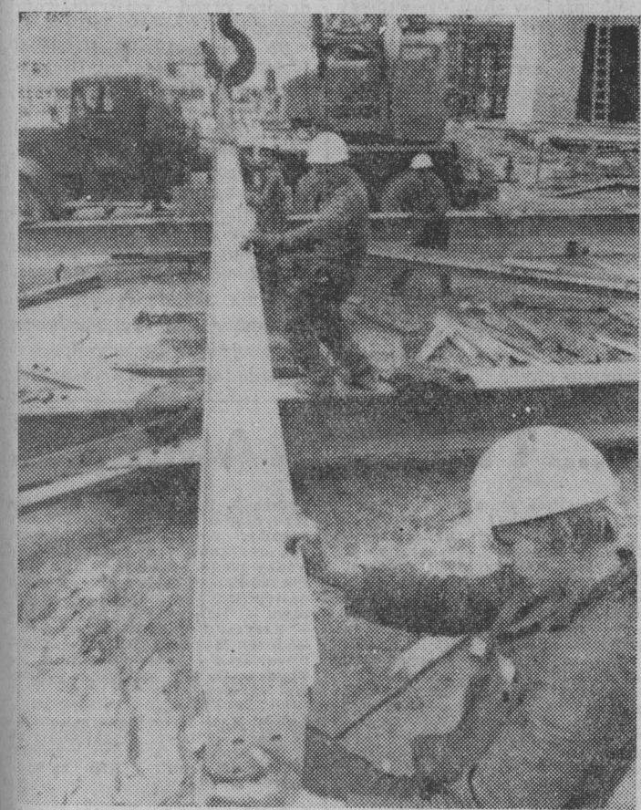
Na budowie Zakładu Chemicznego POLICE II (województwo śląskie) trwają prace montażowe i budowlane na wszystkich odcinkach. Pierwsza instalacja — wytwórnia amoniaku będzie gotowa w 1981 roku. NA ZDJĘCIU: brzoza Adama Klimczaka z Mostostalu Wrocław przy pracy na polu syntetyz amoniaku. CAF—Udmo—teletoto
