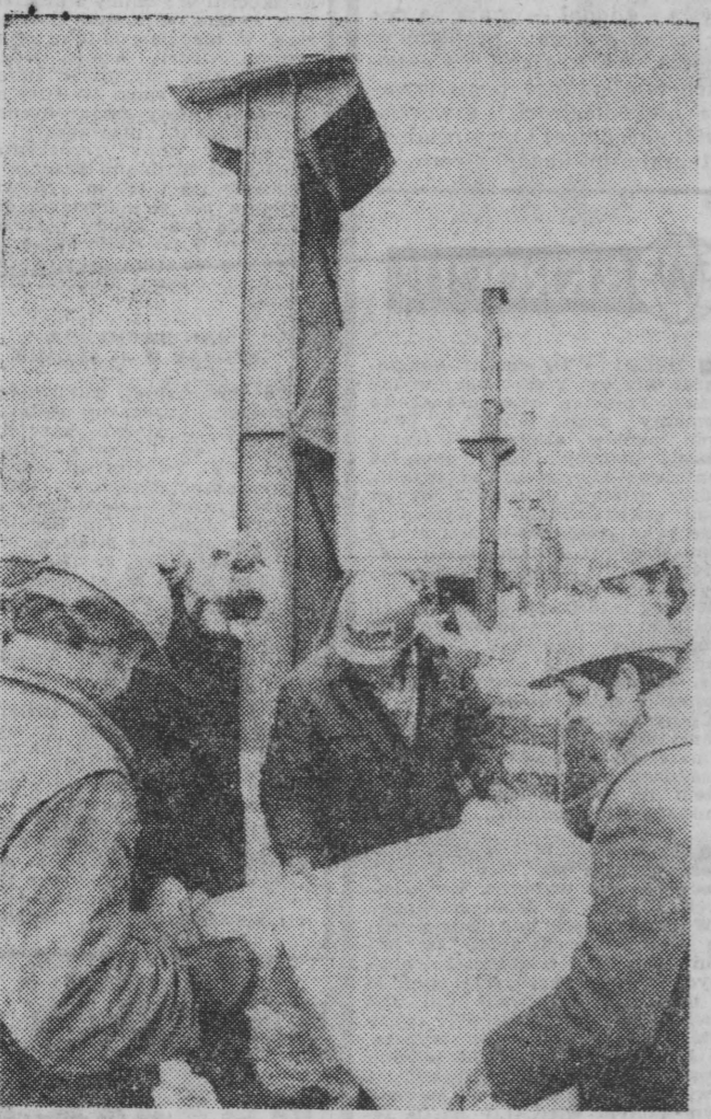
W Lublinie powstaje największa w kraju odlewnia, która pracować będzie dla potrzeb przemysłu motoryzacyjnego. NA ZDJĘCIU: przedstawiciele „Mostostalu” — jednego z wykonawców omawiają szczegóły budowy. CAF — Jaskiewicz — tefeloto
