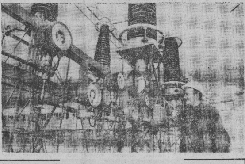
Na górze Żar w Beskidzie Małym powstaje jedna z nielicznych w kraju elektrownia szczytowa - pompowa. Dwa pierwsze turbozespoły Porabki-Zar o mocy 250 MW zostały już próbnie włączone do sieci energetycznej. Docelowo moc 500 MW elektrownia powinna osiągnąć w połowie bieżącego roku. „Porabka” ma za zadanie zagodzić deficyt energii w godzinach tzw. szczytu. NA ZDJĘCIU: Jan Pareja podczas kontroli urządzeń rozdzielni elektrowni. CAF—Sochor—telefoto
