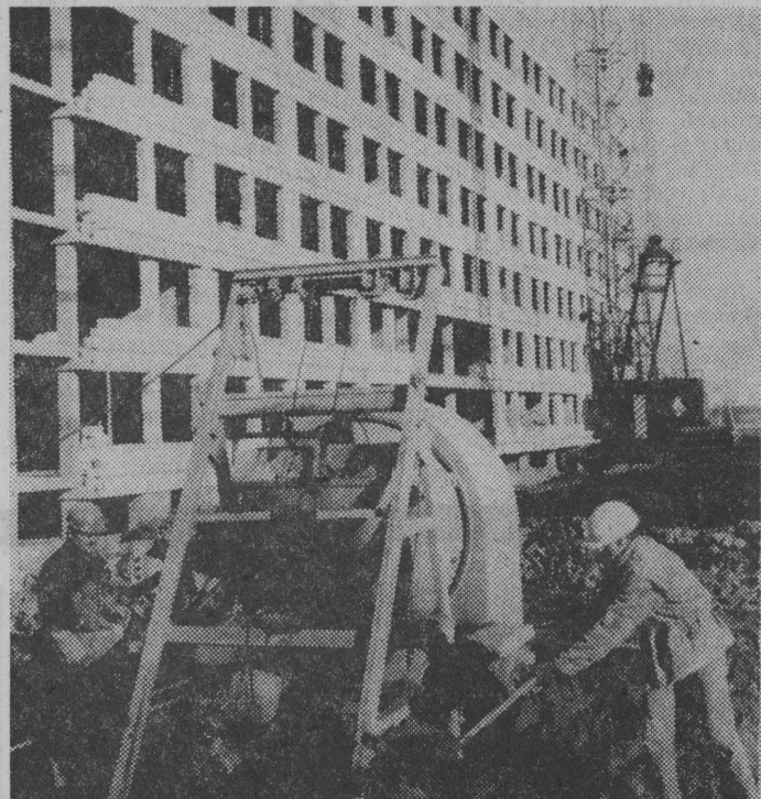
Brгада Mariana Kutakowskiego przy przygotowywaniu zaprawy murarskiej.
