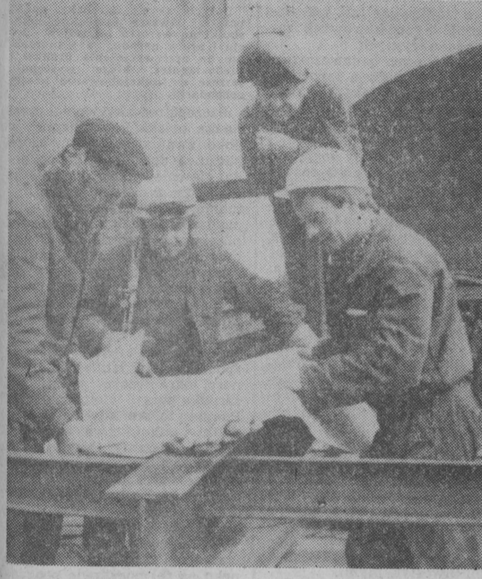
W Zakładach Azotowych we Włocławku w ramach II etapu rozbudowy powstaje kompleks PCW (polichloroku winylu). Do wykonawców włocławskiej inwestycji należy krakowska NAFTOBUDWA. NA ZDJĘCIU: brudga Emilia Mułki przy pracy. CAF—Zotowski—telefoto
