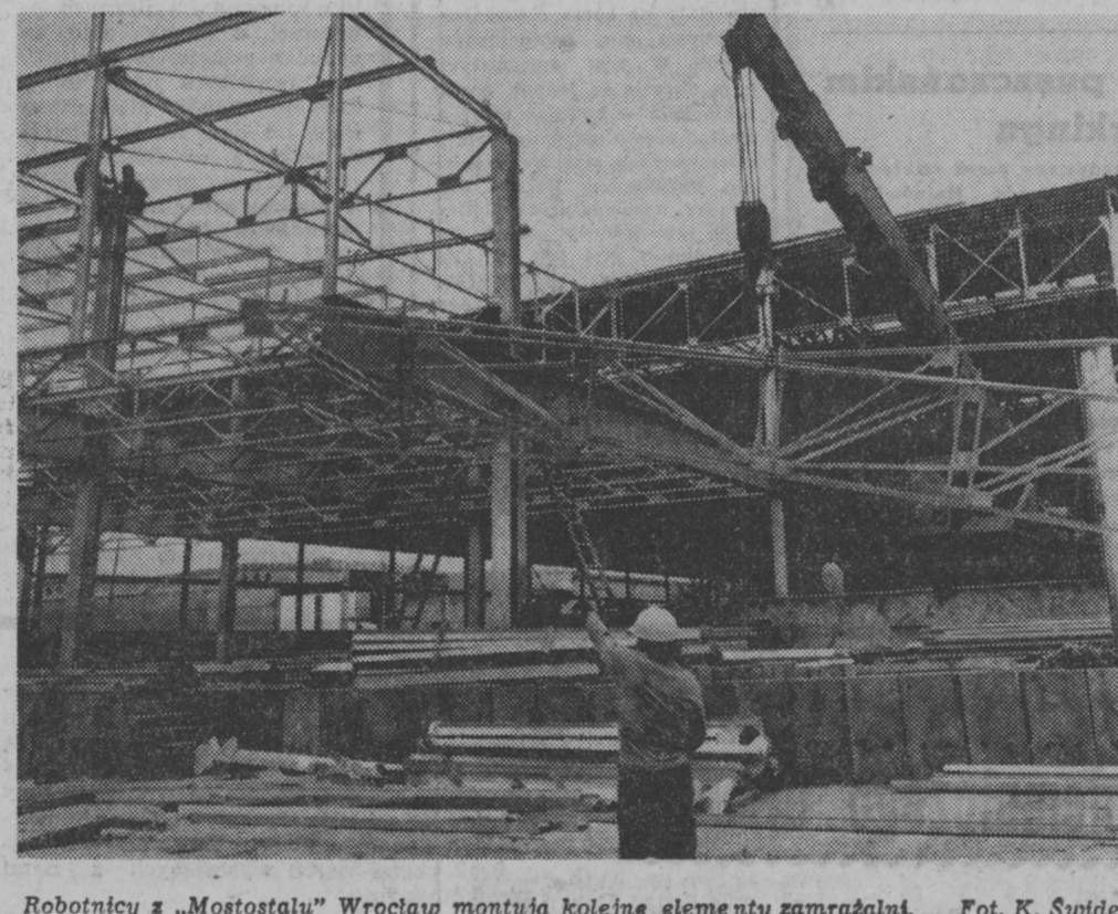
Robotnicy z „Mostostalu” Wrocław montują kolejne elementy zamrażalni. Fot. K. Świdzki
