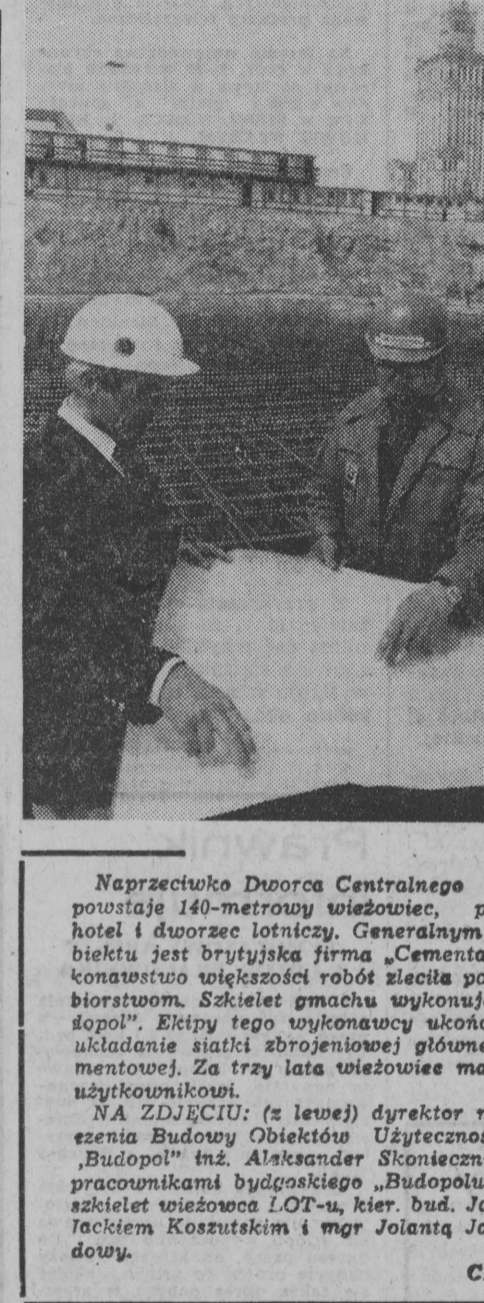
Naprzedkowie Dworca Centralnego w Warszawie powstaje 140-metrowy wieżowiec, przeznaczony na hotel i dworzec lotniczy. Generalnym wykonawcą obiektu jest brytyjska firma „Cementation”, która wykonawstwem większość robót zleciła polskiemu przedsiębiorstwu „Skielet gmachów wykonuje bydgoski „Budopol”. Ekipy tego wykonawcy ukończyły niedawno układanie siatki zbrojeniowej głównej płyty fundamentowej. Za trzy lata wieżowiec ma być przekazany użytkownikowi.
