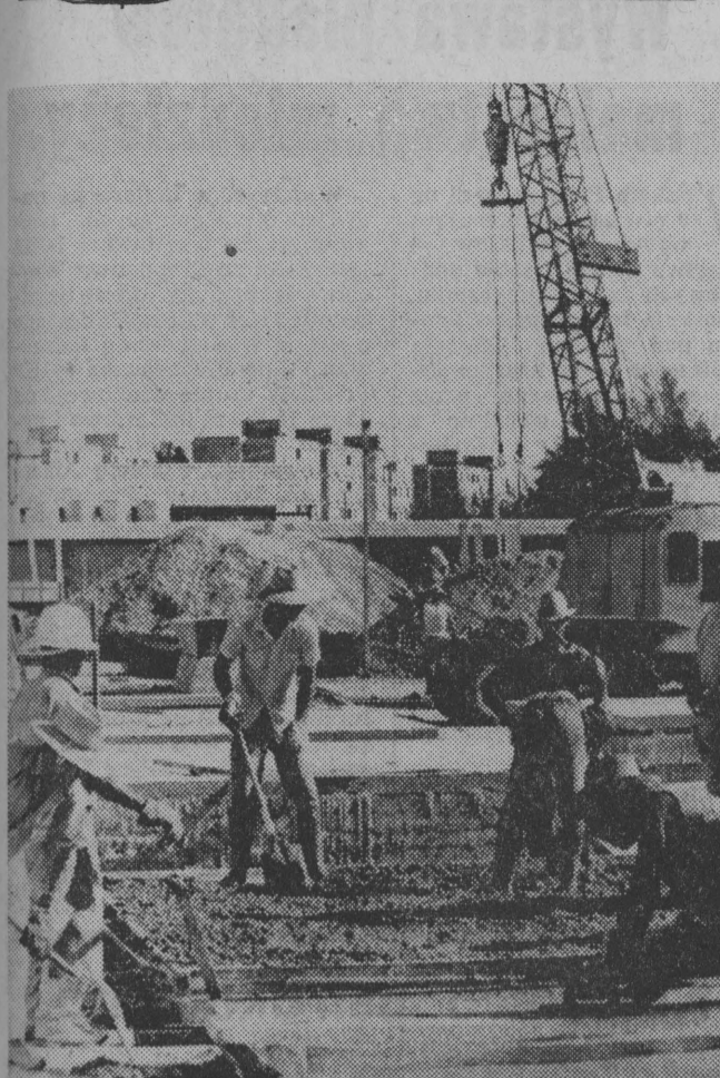
KUBA. Prace remontowe na terenie Hawany przed zbliżającym się festiwalem. GAF—Prensa Latina
