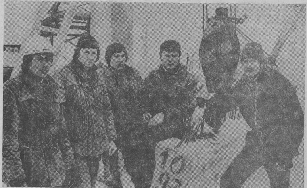
W ostatnim okresie znacznie zwiększyło się tempo prac przy budowie Fabryki Domów w Suwałkach. NA ZDJĘCIU: produkująca brygada montażystów, kierowana przez RYSZARDA RADZEWICZA.
