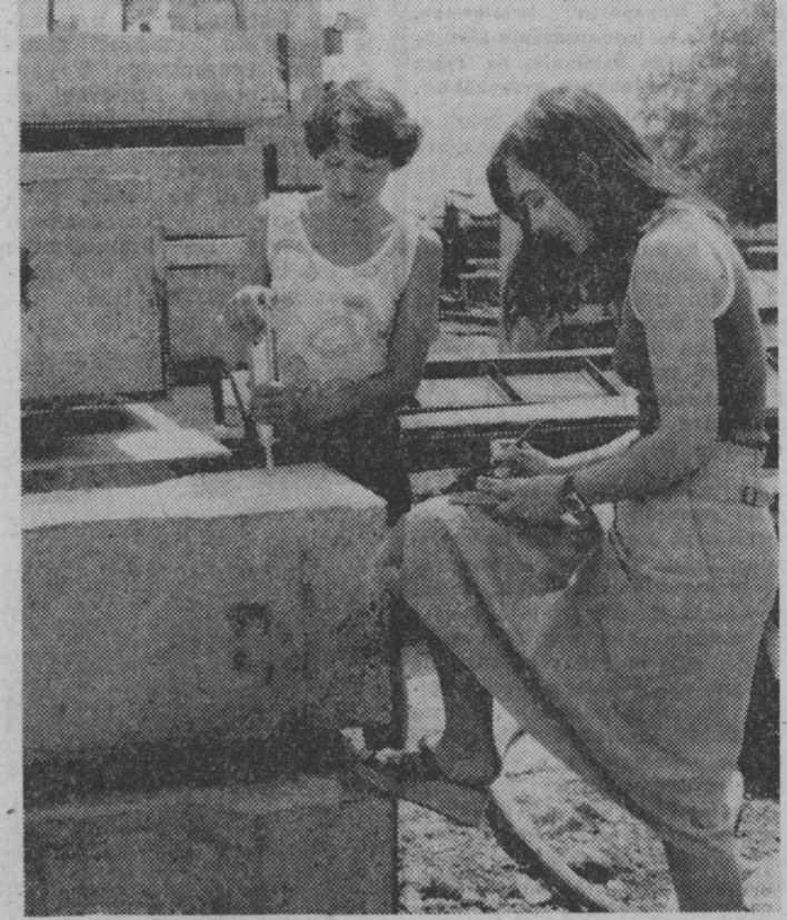
Krystyna Niemyska (u góry) i Wanda Nowakowska badają wytrzymałość elementów prefabrykowanych przy pomocy sklerometru.
