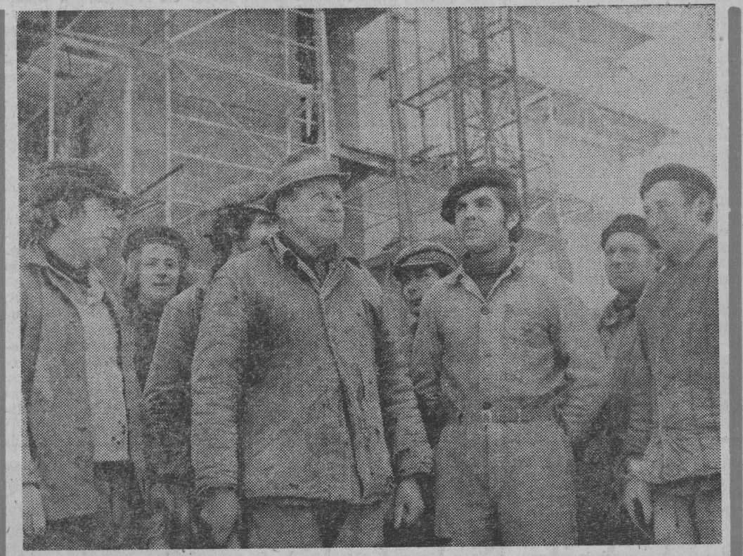
Brigada Bronisława Jurkowskiego zalicza się do najlepszych na placu budowy Politechniki Białostockiej. Ambicją budowlanych jest przekazanie do końca roku Domu Studenckiego nr 2
