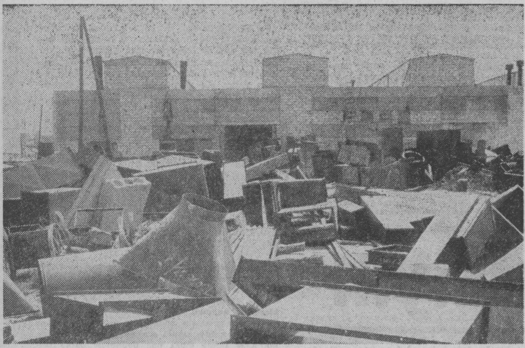
Elementy instalacji czekają na... Godota.
