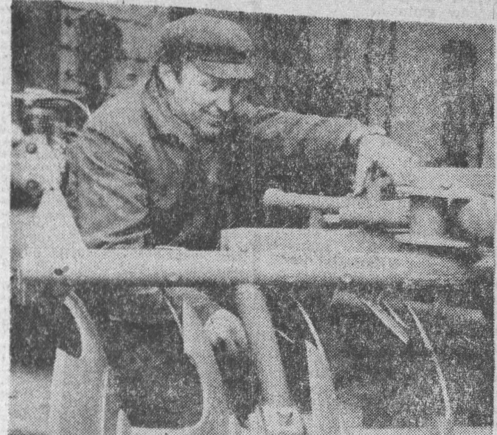
SKR Suwałki. Mieczysław Tyczkowski stwierdza, że brzo na talerzowa po naprawie jest w pełni sprawna. Fot. Z. Zaremba
