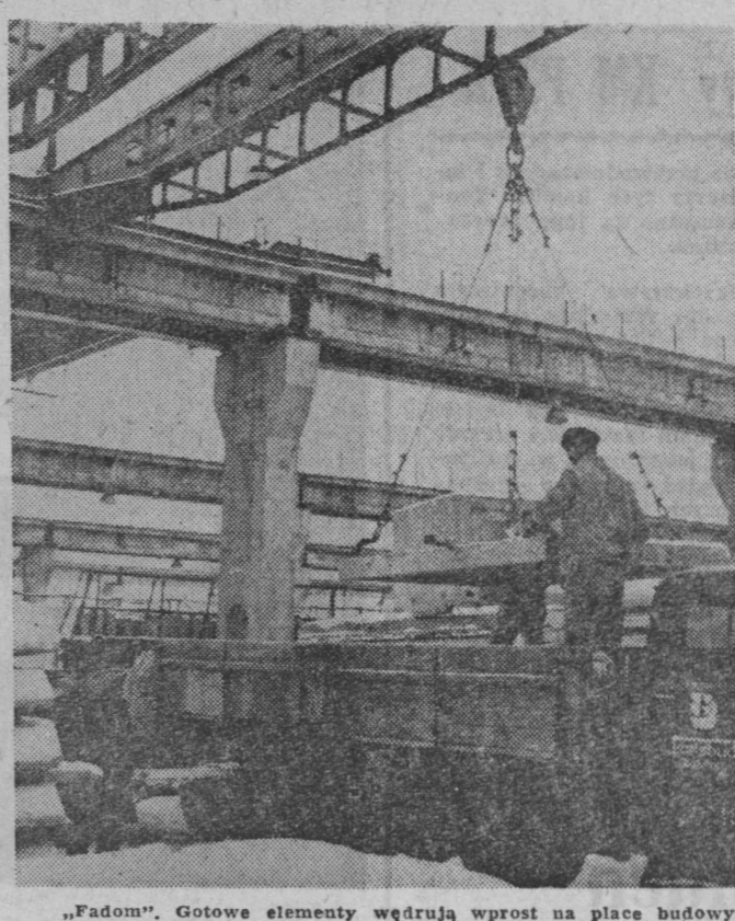
„Fadomek”. Gotowe elementy wędrują wprost na place budowy.
