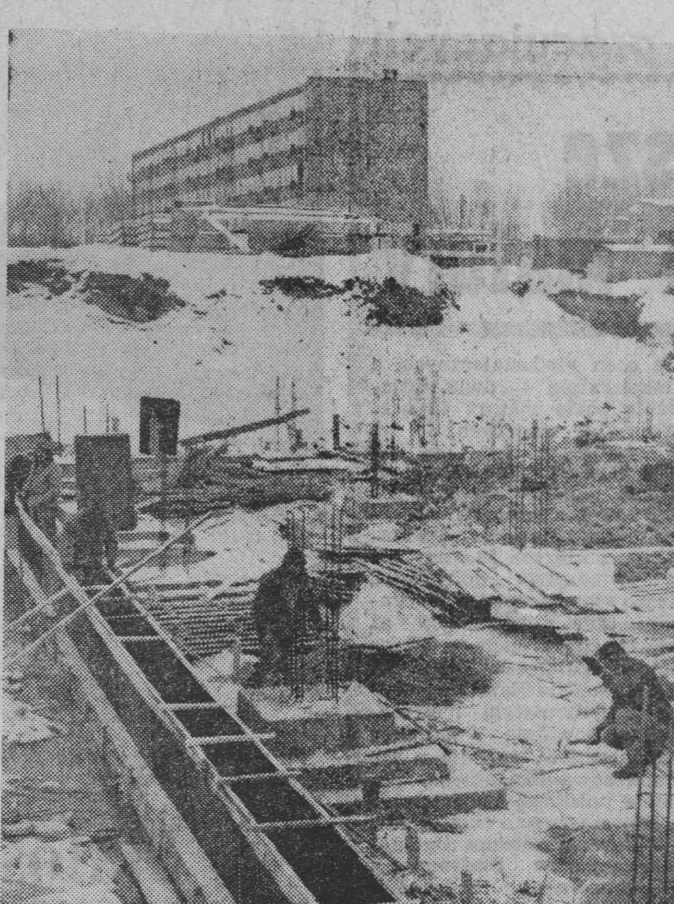
Pracująca brygada Kazimierza Prończuka przy budowie jednego z obiektów Fabryki Mebli w Białymstoku.
