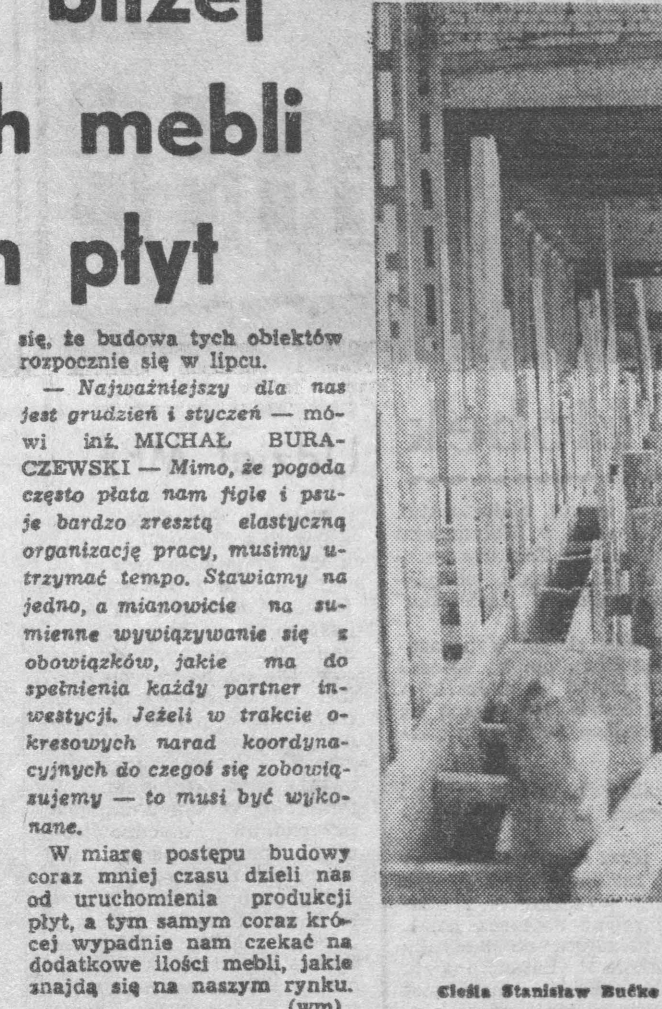
Cieśla Stanisław Bućko przy budowie kanału technologicznego.
