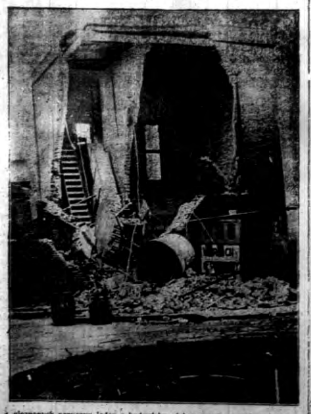
nieznanych przyczyna jeden z budynków fabrycznych został zniszczony wskutek wybuchu gazu.
