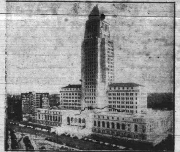
W mieście wielkiej Olimpiady 1932 — imponujący gmach nowego ratusza w Los Angeles.
