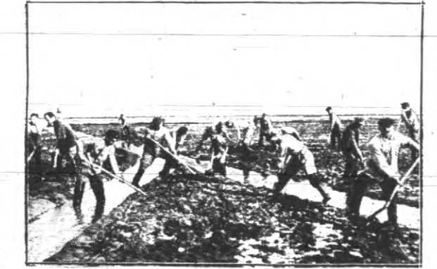
Roboty odwadniające na północnym wybrzeżu Niemiec, koło Hamburga, zmierzające do powiększenia terytorium nadmorskiego o kilkadziesiąt kilometrów kwadratowych.
