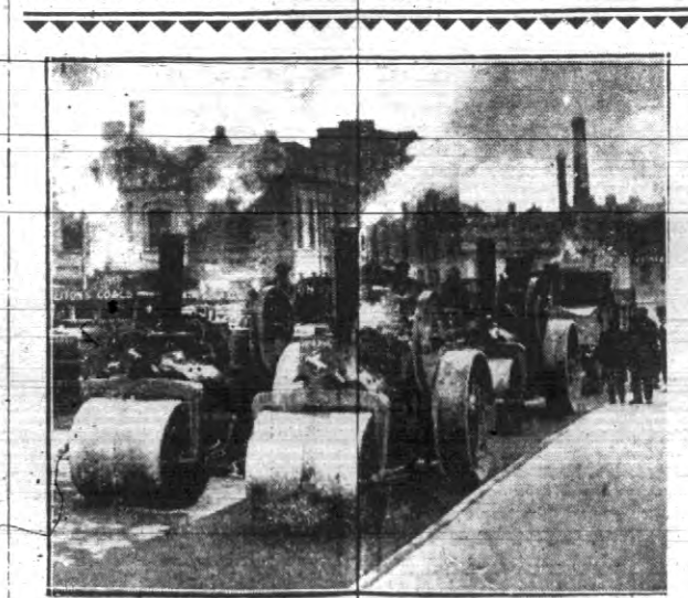
Generalna próba wytrzymałości nowego mostu w Dublinie (Irlandia) — dokonywana przy pomocy zdeformowanych walców drogowych.
