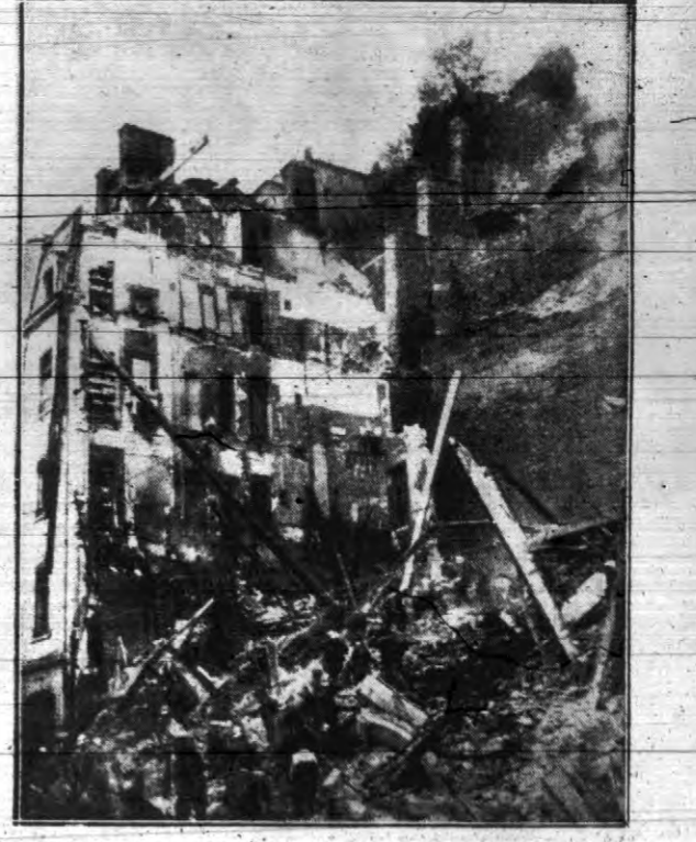
Trzydzieści osób znalazło śmierć w ruinach dwu domów w Lyonie (Francja), zawałonych skutkiem obsunięcia się ziemi. Na zdjęciu — akcja ratownicza wśród gruzów.
