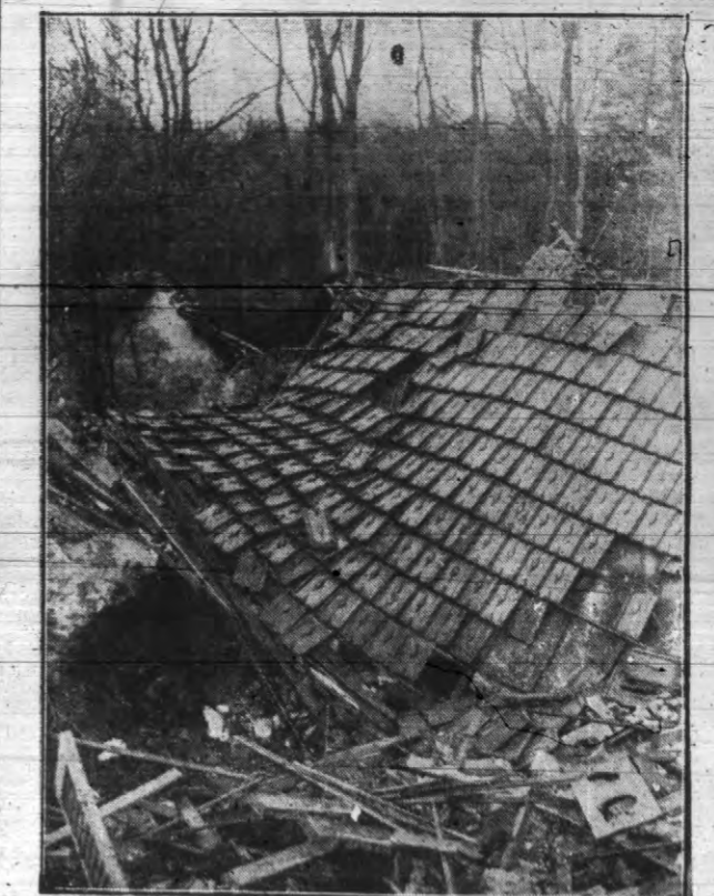
Miejsce niezwykłej katastrofy: dom w Orosne (Francja) skutkiem podmycia przez rzekę zawalił się, przywalając 11 ludzi. Nikt jednak, cudem, nie odniósł poważniejszych obrażeń.
