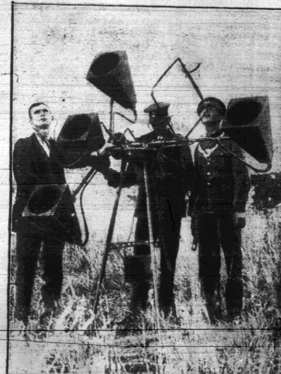
Uszy armji — precyzyjne aparaty podsłuchowe, przeznaczone do chwytania hałasu nadlatujących samolotów nieprzyjacielskich. Czułość tych aparatów jest tak wielka, że po nateżeniu szmeru można rozróżnić nawet typ lecących aparatów.
