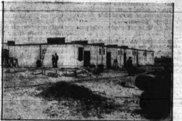
Nowe domki na kolonii dla bezdomnych w Warszawie. Oby ich budowano jaknajwięcej..
